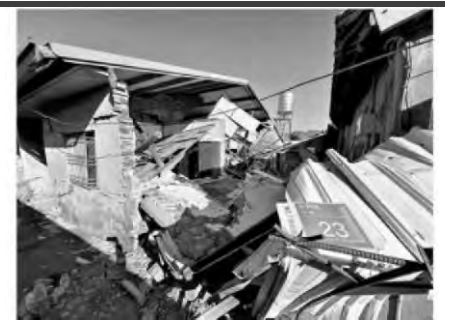
圖：台南市楠西區一處民宅在地震中嚴重受損。\\新華社
